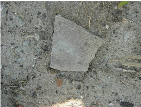
Foto 3: asbestverdacht fragment op maaiveld
