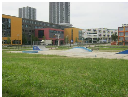
Foto 2: Het verharde deel is in gebruik als skate-park met een verhardingslaag van stelconplaten.
