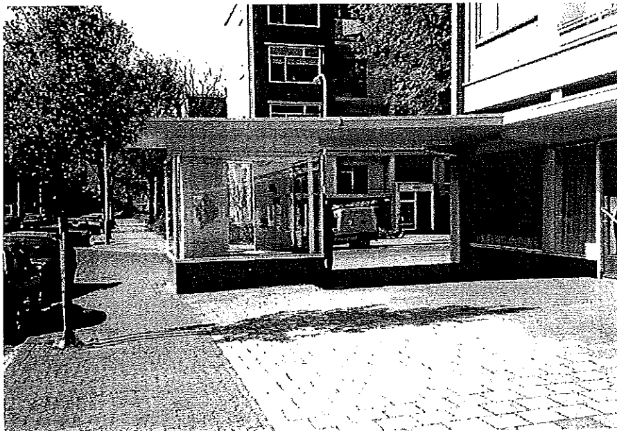
De vormtaal van het winkelcentrum De Dreef is kenmerkend voor de wederopbouw-architectuur.
