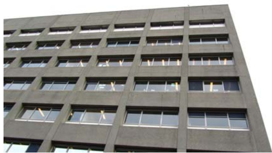
Foto 3: Loosduinseweg nummer 15, hoofdgebouw, zelfde gebouw als op de voorzijde van het rapport.
