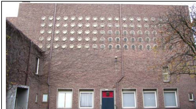
Foto 9: De kerk met links de aanbouw waar de spouwgaten in zitten.
