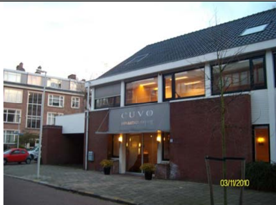
Foto 7: Uitvaartcentrum aan de Boutersemstraat, gefotografeerd vanaf de oostkant, naast de Zamenhofstraat. Links is de garage.
