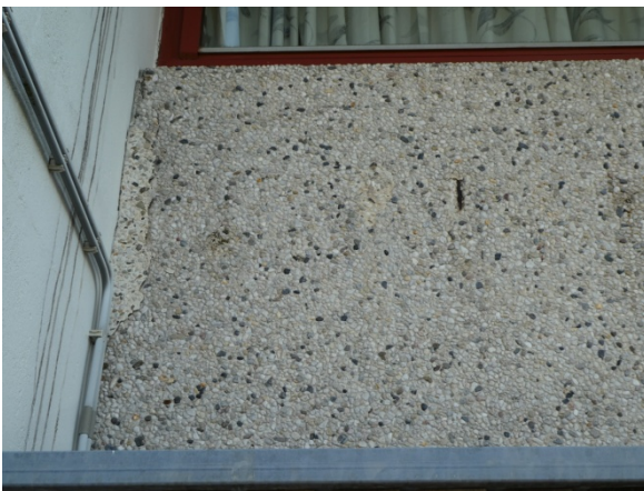
Borstweringen met uitgewassen grind, links jaren 70, rechts jaren 80 van de 20 e eeuw.
