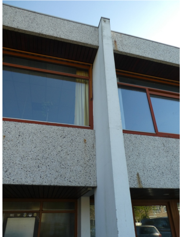
Deel gevel jaren 70, Livingstonelaan.
