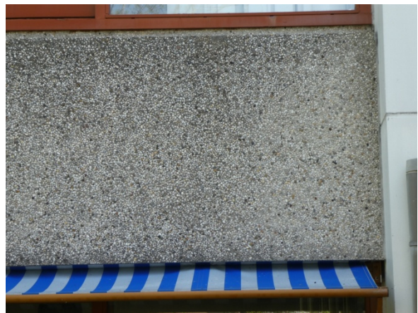
Borstweringen met uitgewassen grind, links jaren 70, rechts jaren 80 van de 20 e eeuw.
