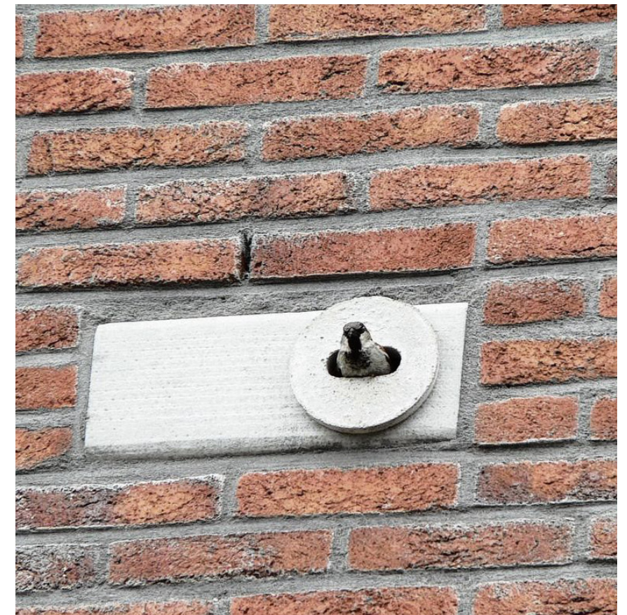
nestkasten voor huismussen in gevel
