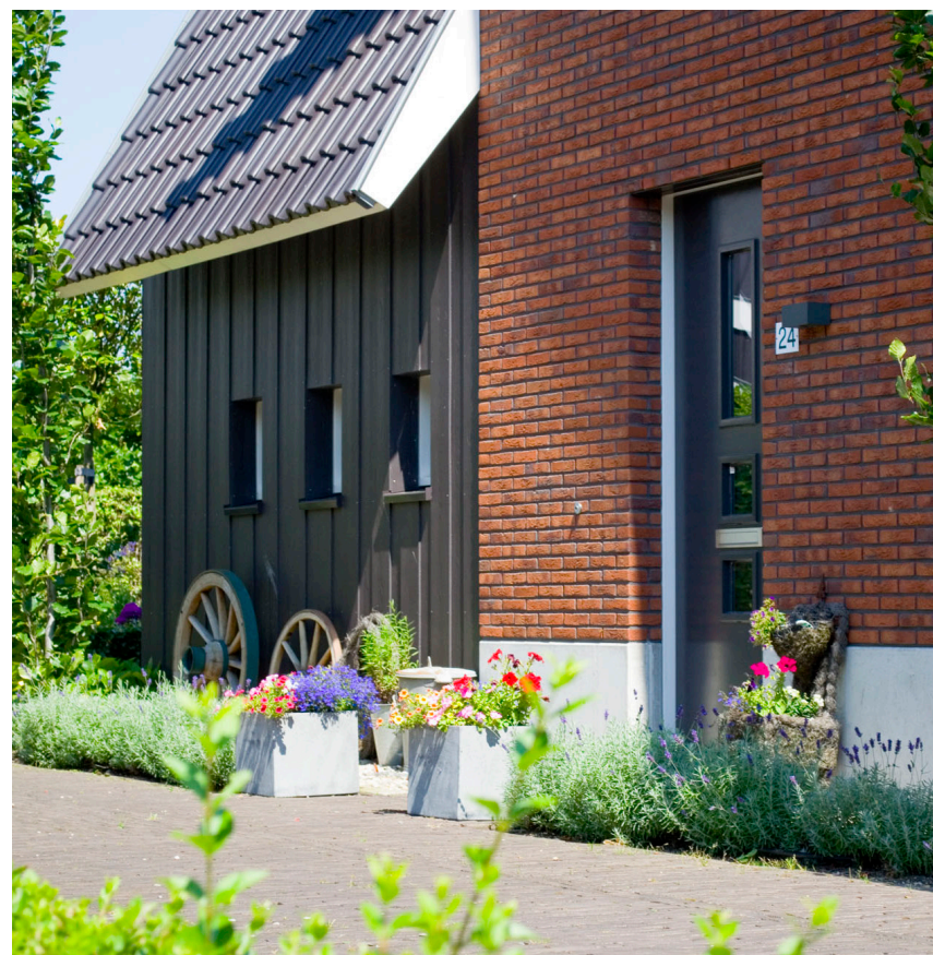
combinatie van houten delen en metselwerk
