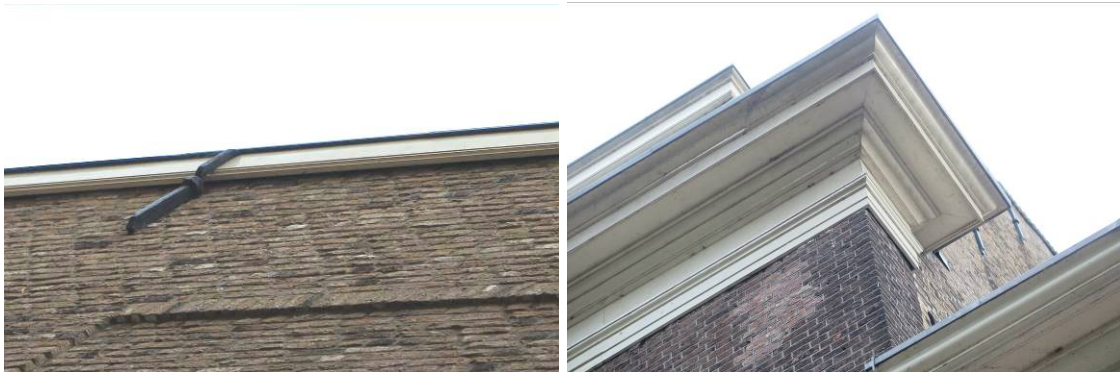
Figuur 4. Daklijsten van het Weeshuis-complex te Gouda die toegang kunnen bieden aan vleermuizen.
