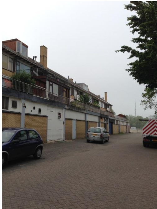
Woningblok aan De Rijkestraat (achterzijde)
