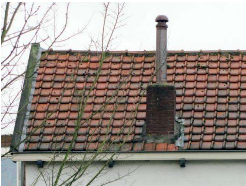
Figuur 8: Dakbedekking van het huidige woonhuis.
