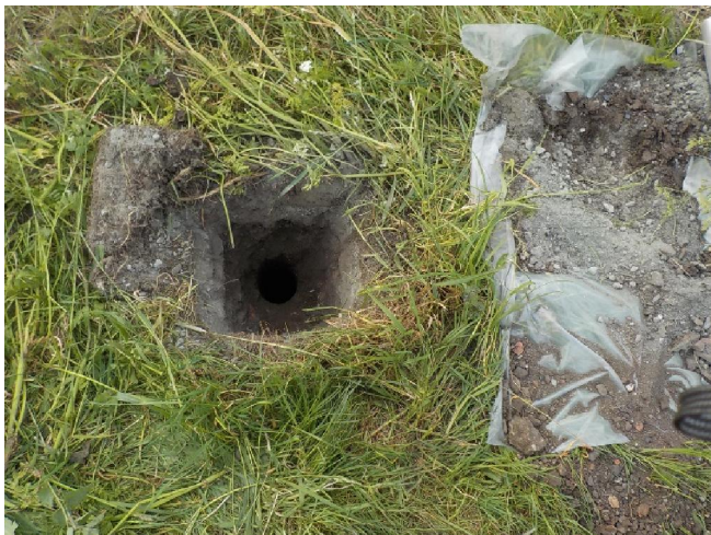
Foto AG 01 gegraven inspectiegat t.p.v. dam
