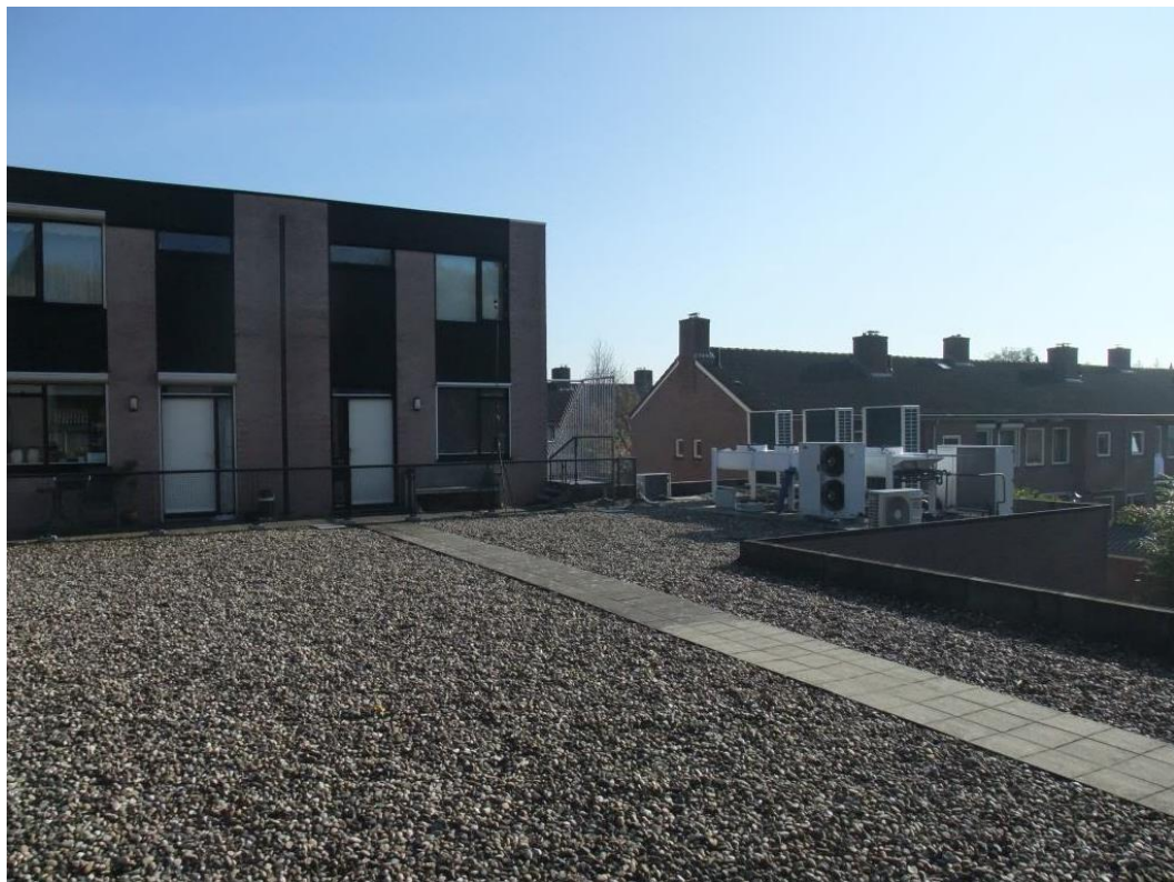
Zicht op MP1 met installaties LIDL
