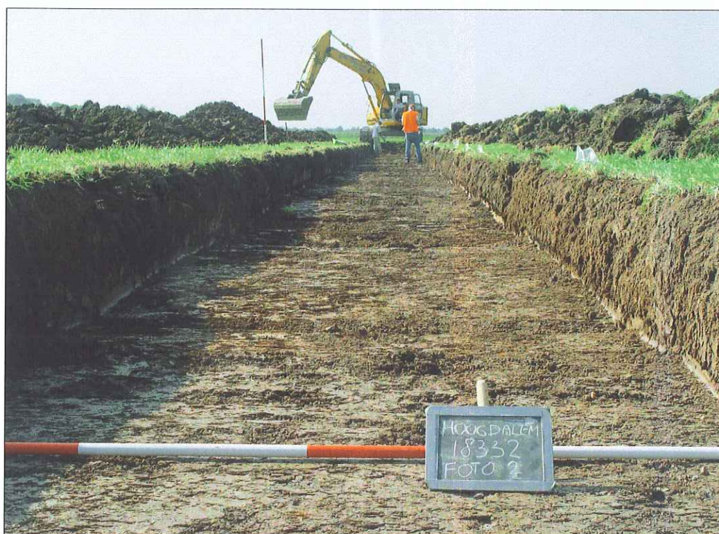
Afb. 3: De aanleg van de eerste proefsleuf. De bouwvoor is apart gehouden van de rest van de uitgegraven grond, om het perceel in zo goed mogelijke staat weer te kunnen opleveren.
