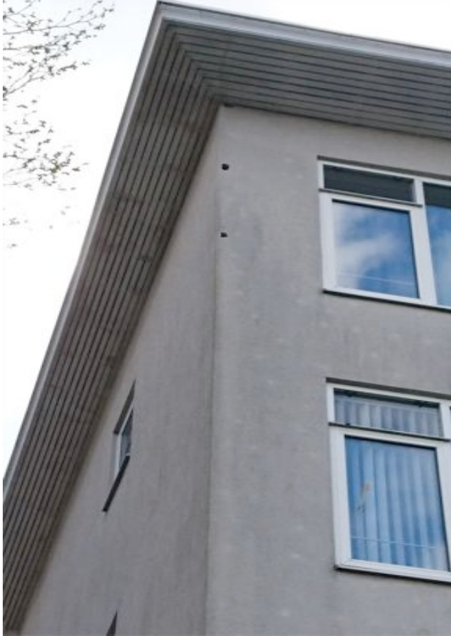
Gaten in gevelvlak hoogbouw waar vleermuizen gebruik van zouden kunnen maken
