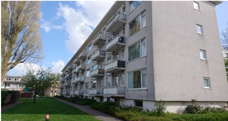
Hoogbouw langs de M.H. Tromweg
