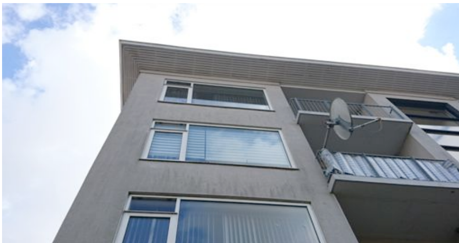
Betimmering dakoverstek hoogbouw, met kieren waar vleermuizen gebruik van zouden kunnen maken
