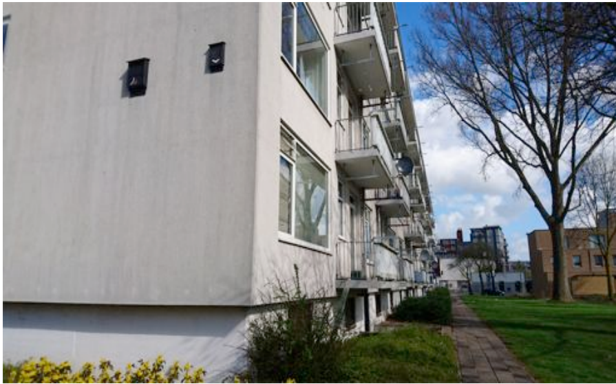
Vleermuiskasten op hoogbouw langs de M.H. Tromweg
