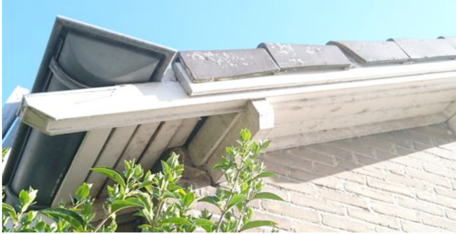
Dakoverstek laagbouw met spleten en kieren geschikt voor vleermuizen
