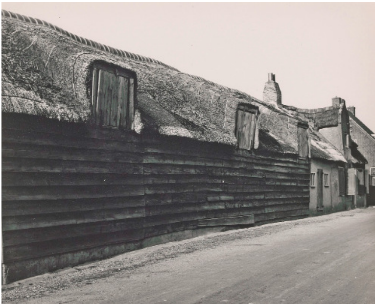
Afb. 10. De van oorsprong 17 e -eeuwse boerderij die aan de Vissersdijk binnen het onderzoeksgebied stond. De boerderij is in 1965 afgebrand. De foto dateert uit de periode 1955-1964 en is genomen vanaf de Vissersdijk in noordelijke richting (RAD inventarisnr. 623_5443).
