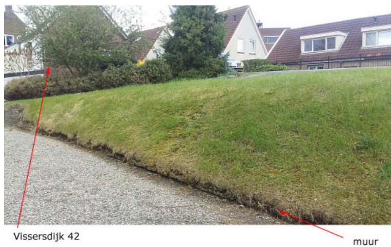
Afb. 16. Boven: de woonheuvel aan de Vissersdijk waarop tot 1965 het schuurdeel van de 17 e -eeuwse boerderij stond. Op de achtergrond het huis Vissersdijk 42, het oorspronkelijke woondeel van de boerderij (gezien in noordoostelijke richting). Onder: de voet van de woonheuvel met onderin een muurrestant (gezien in de richting van de Vissersdijk).
