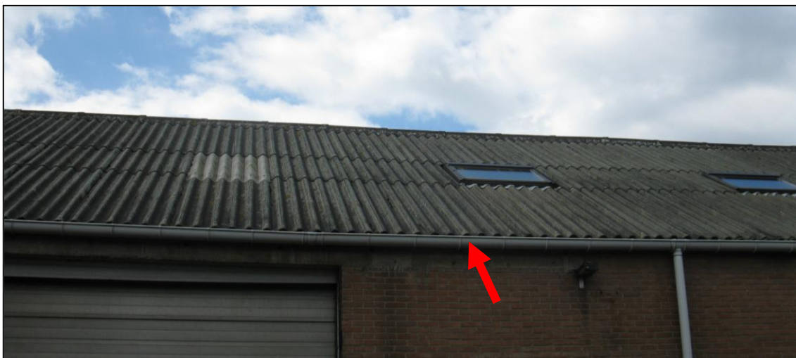
Foto 10: Ruimtes onder golfplaten geschikt voor de Huismus
