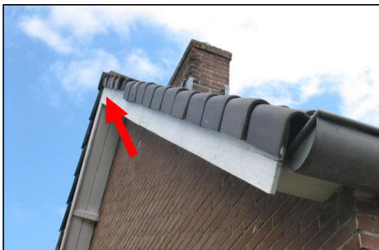
Foto 8: Ruimtes onder dakpannen geschikt voor de Gierzwaluw
