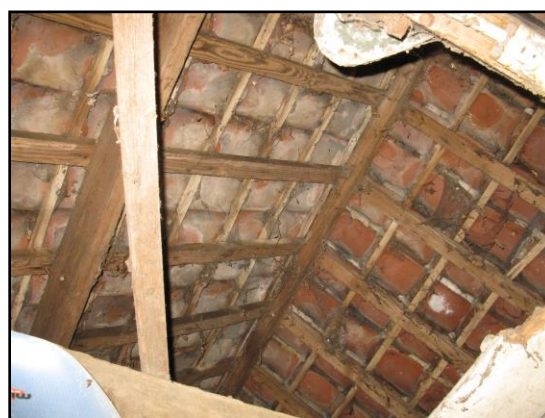
Foto 8: Houten dakconstructie met dakpannen
