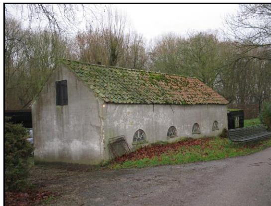
Foto 2: Monumentale schuur van baksteen
