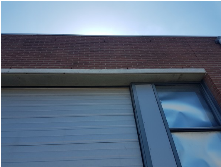
Afbeelding 6. Open stootvoegen in plangebied, welke op dit moment ongeschikt zijn gemaakt voor vleermuizen.
