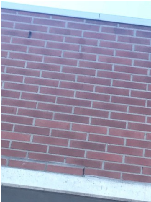
Afbeelding 7: Dicht gekitte open stootvoegen. Foto: opdrachtgever.
