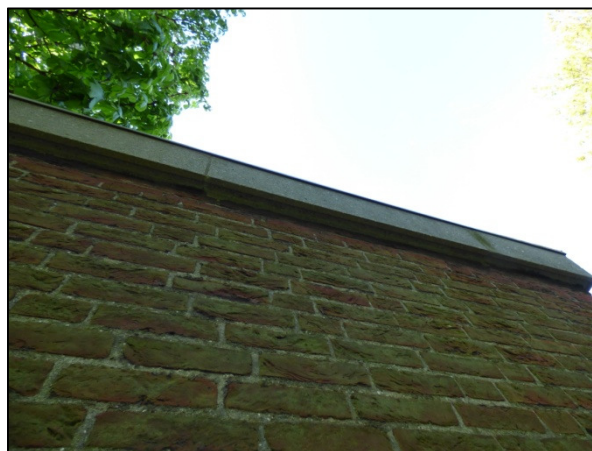
Foto 2: Muren zonder open stootvoegen en strak afgewerkte dakrand
