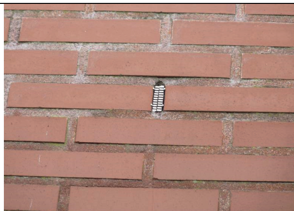
Figuur 11. Er zijn stootvoegen aanwezig, maar deze zijn allen afgedekt.
