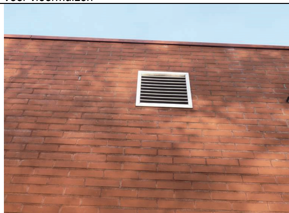
Figuur 12. Er zijn ventilatieroosters in het gebouw aanwezig met daarachter fijnmazig gaas
