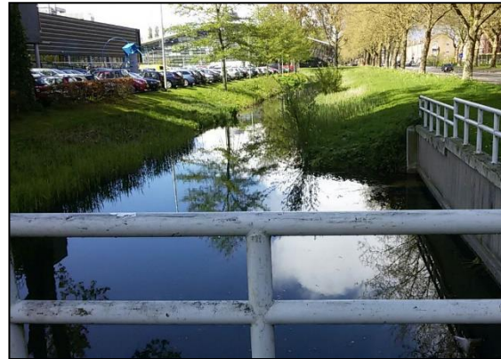
Foto 4: Watergang voorzien van flauwe oever
