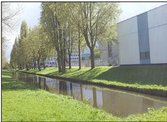
Foto 3: Watergang voorzien van flauwe oever
