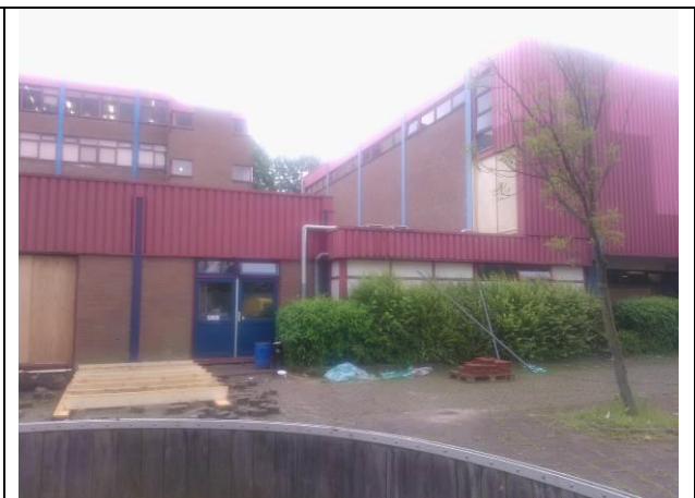
Foto 2. Hoofdgebouw, sportzaal en bijbouw
