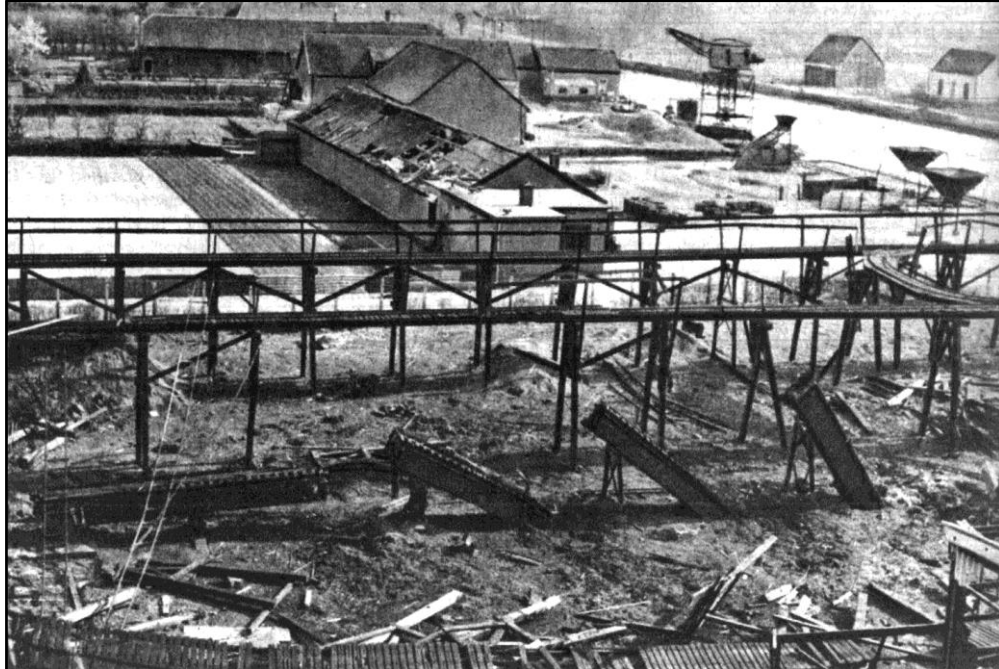
Figuur 3 Het terrein van de Lijm- en Gelatinefabriek na vernielingen op 29 maart 1945. De lanceerinstallatie van de V1 (voorgond) is in een aantal stukken opgeblazen (bron: J.W. de Blij, Oorlog en verzet in de Prinsenvstad 1940-1945. Een overzicht van de gebeurtenissen in Delft in en rond de bezettingstijd , Delft, 2005, pag. 264).
