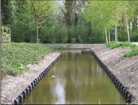
Figuur 27. Kunstmatig beschoeide oever zoals in Noordwest 3 op diverse plaatsen aanwezig: ongeschikt voor vissen en amfibieën.
