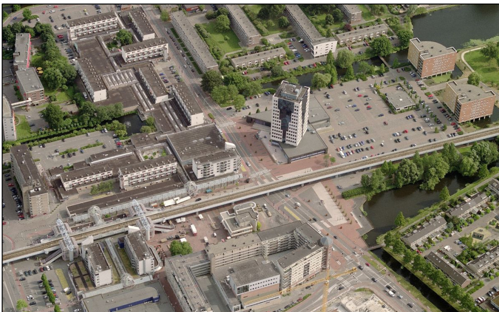
Luchtfoto's plangebied in vogelvluchtperspectief vanuit verschillende windrichtingen met weergave winkelcentrum De Koperwiek, Stadsplein, metrobaan met station en rest van de omgeving. Bron: Bingmaps, 2013.
