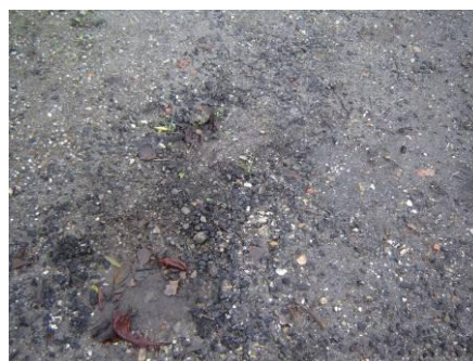
Foto 9: Asfalt en grind verharding.
