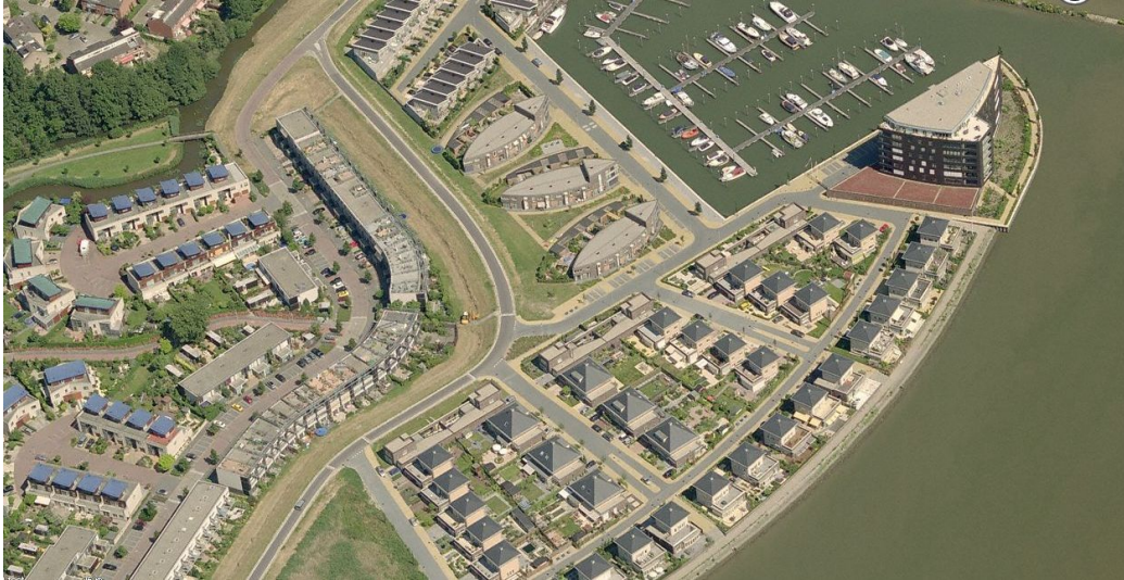
Figuur 16: Luchtfoto van Paradijsseel en klein deel van jachthaven 't Zandrak (bron: BingMaps)
