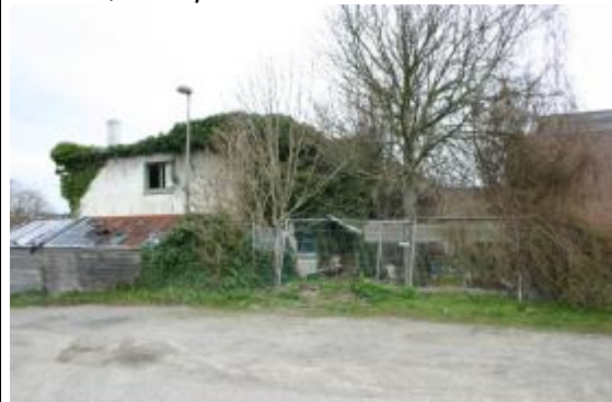
Foto 16, te slopen ruïne Stuive Omzicht
