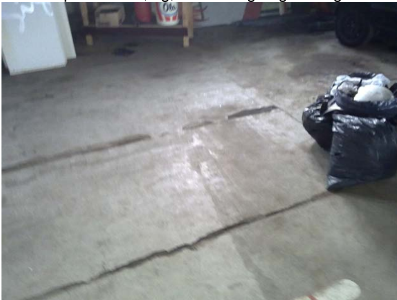
Foto 12: pand nr. 88, bg, vloer van garage 2 → geen asbest
