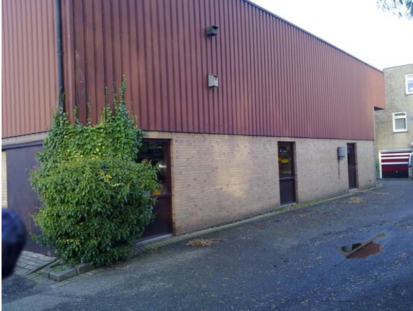
Foto 7: pand nr. 96, kit bij raamkozijnen → niet asbesthoudend
