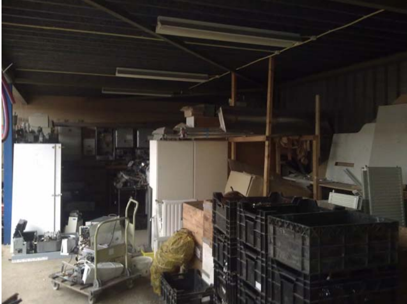
Foto 1: pand nr. 96, 1 e verdieping (staal dak en een houten vloer)
