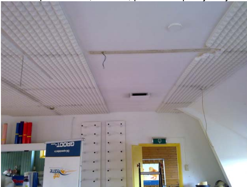
Foto 10: pand nr. 88, 2 e verd., plafond en plaatjes zijn van hout → geen asbest
