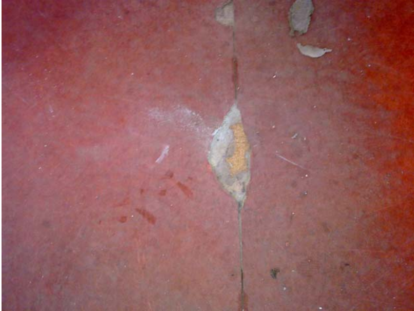
Foto 9: pand nr. 88, linoleum op houten vloerplaten → niet asbesthoudend
