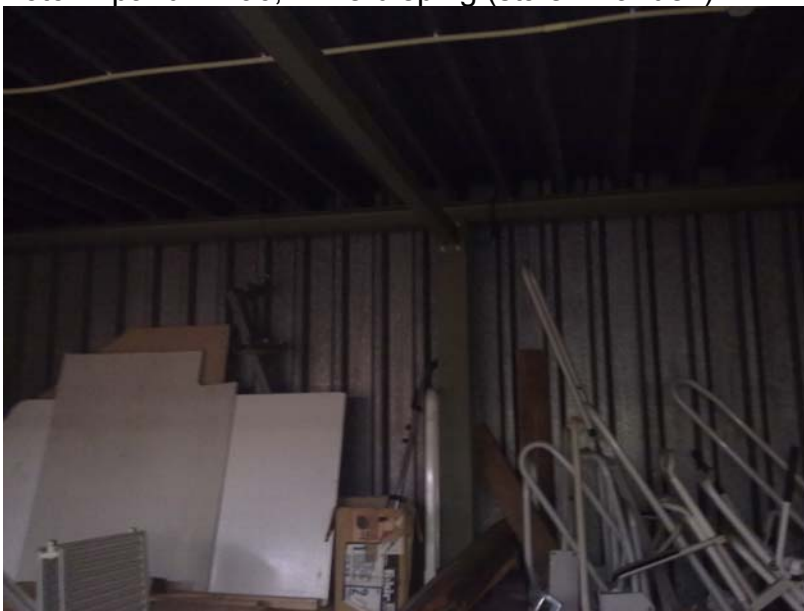
Foto 2: pand nr. 96, 1 e verdieping (stalen wanden)
