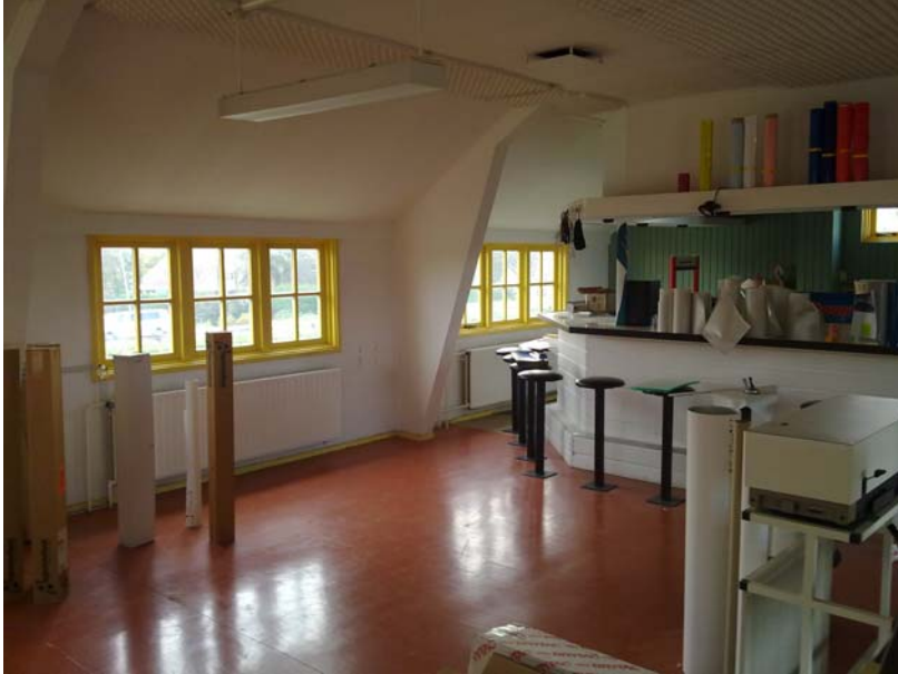
Foto 11: pand nr. 88, 2 e verd., plafond en plaatjes zijn van hout → geen asbest
