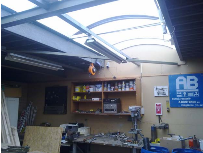
Foto 3: pand nr. 96, 1 e verdieping (houten voorzetwand en een staal dak)
