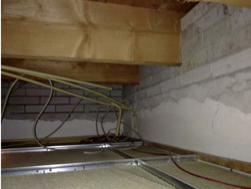
Foto 5: pand nr. 96, boven het plafond van de begane grond → geen asbest
