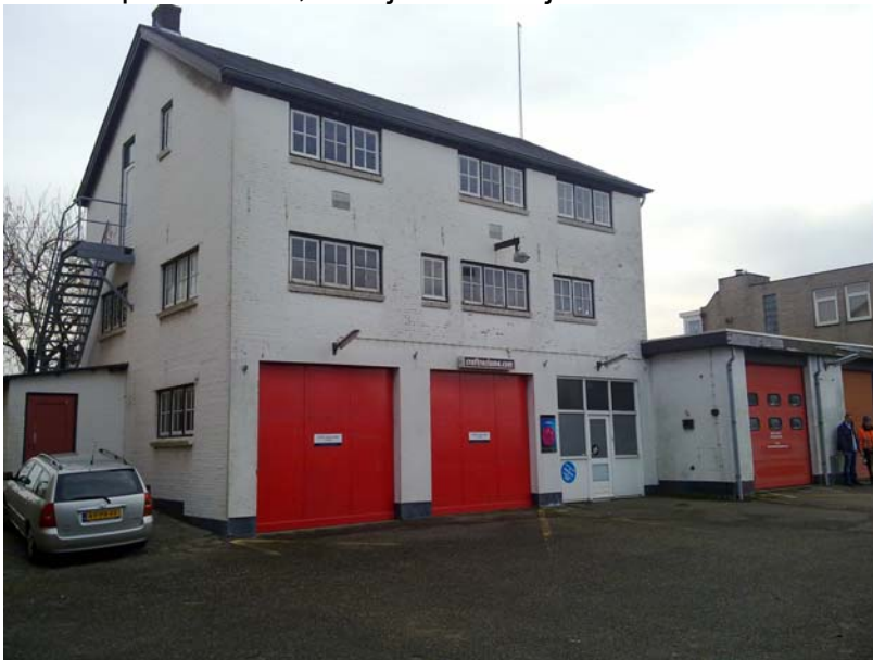
Foto 8: pand nr. 88, kit bij raamkozijnen → niet asbesthoudend
