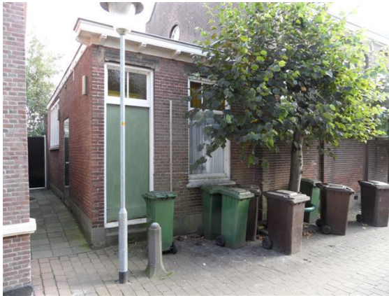
De te slopen consistorie.
