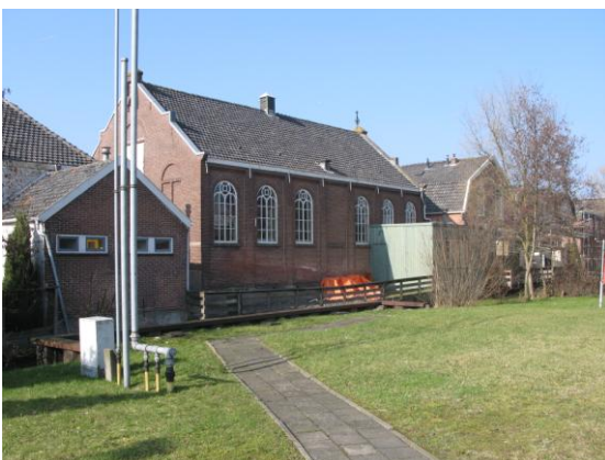
Het kerkgebouw vanaf Alphenseweg. De houten uitbouw zal worden gesloopt.
