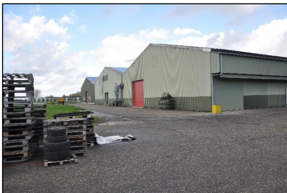
Afb 3: Achtergevel van het gebouw
