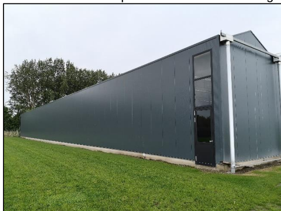
Afb 3: Strakke gevel zonder openingen
