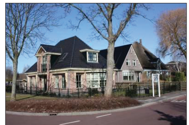
Nieuwbouw gebaseerd op traditionele gebiedseigen bouwvorm.
