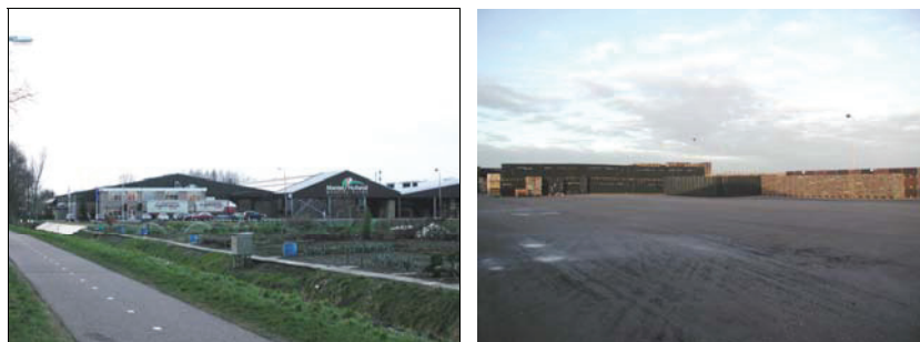
Noordzijde perceel en opslag materiaal
