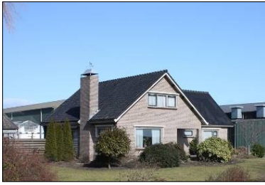
Woning met gemetselde gevels en dakpannen als dakbedekking.
