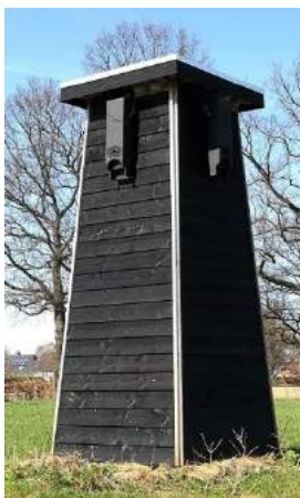
Figuur 2. Combinatietoren met verblijfplaatsen voor vleermuizen en huiszwaluw (direct onder de dakrand)
