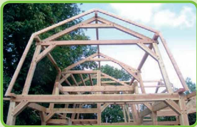
HOUT SKELET BOUW
