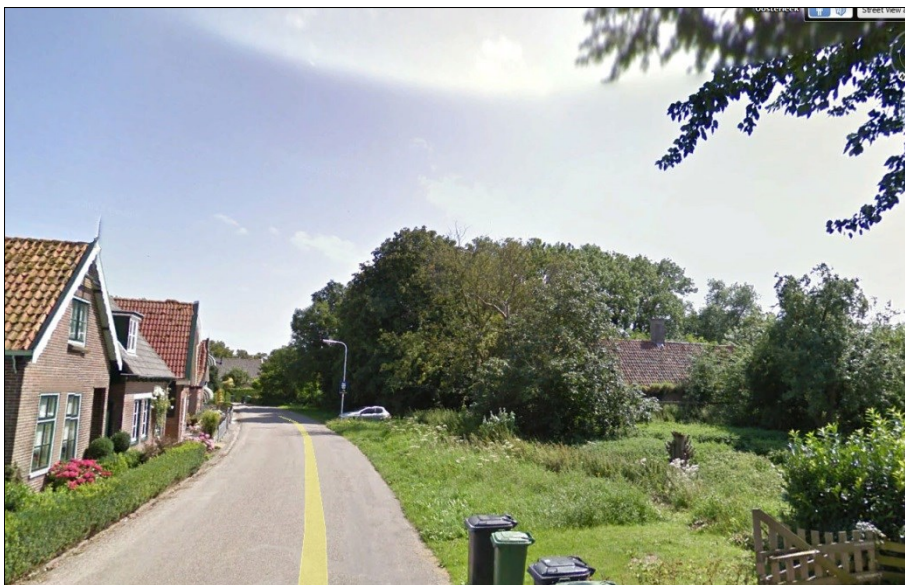
Figuur 3. Aanzicht vanaf de Oosterleek met het perceel Oosterleek 39 aan de rechterzijde (bron: Google Streetview)
