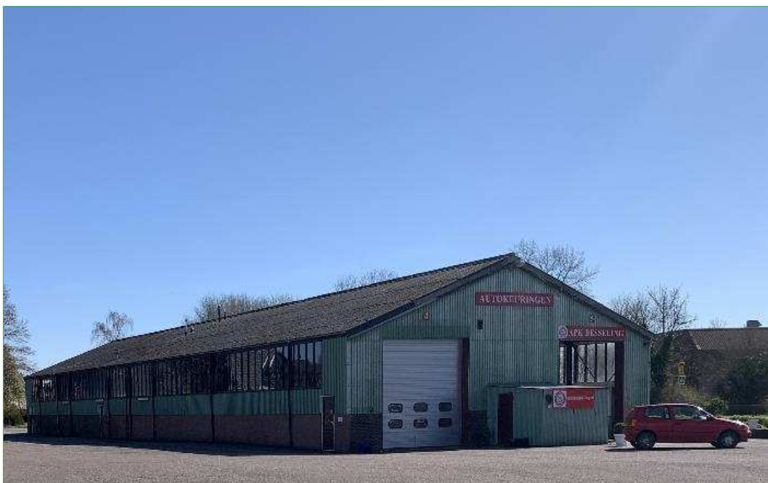
De loods in het zuidoosten van het plangebied.
