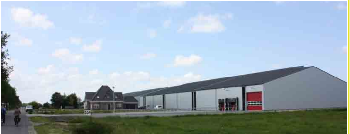
Bedrijfsloodsen dwars op de kavelrichting (4)
