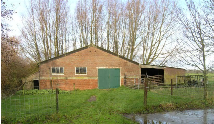
Figuur 5. Te slopen bebouwing
