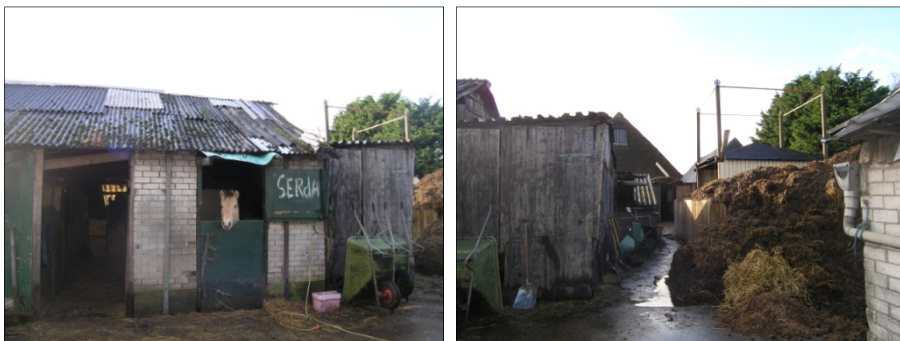
Figuur 5. Te slopen bebouwing
