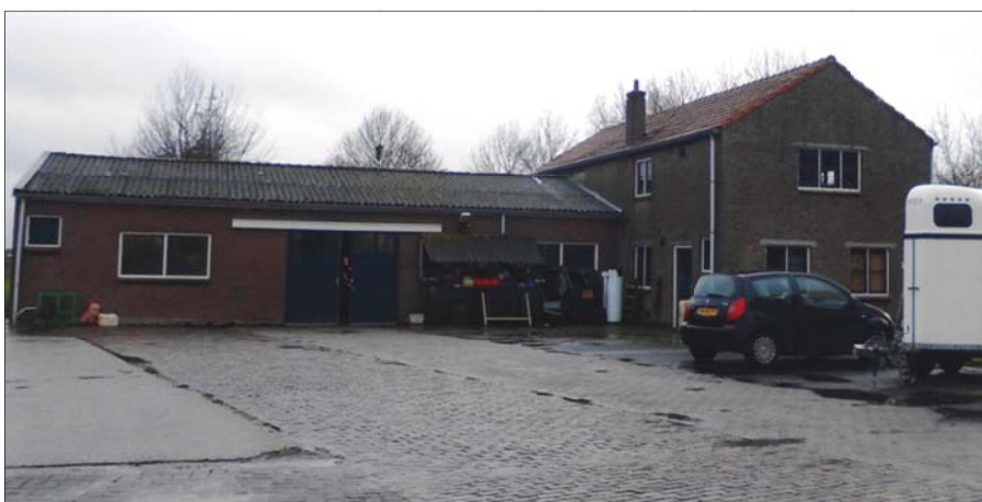
Figuur 5. Te slopen bebouwing
