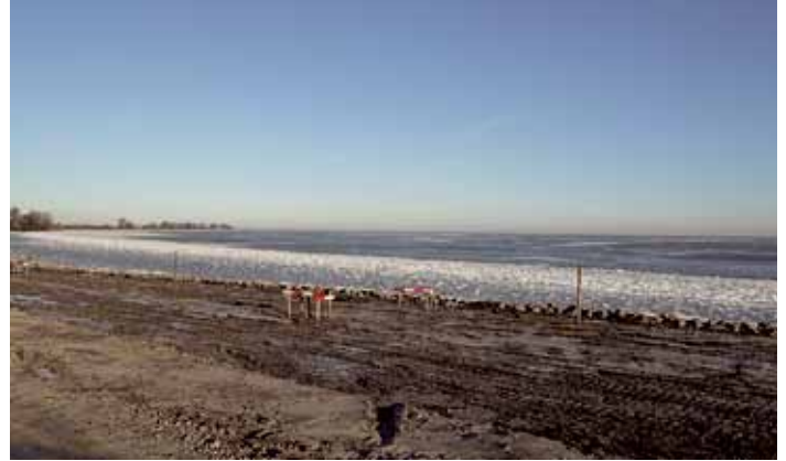
Dijkversterking tussen Enkhuizen en Hoorn.
