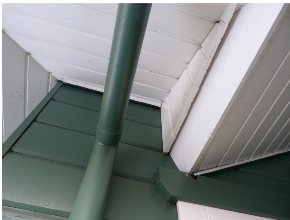
Figuur 3. Voor vleermuizen toegankelijke openingen.
