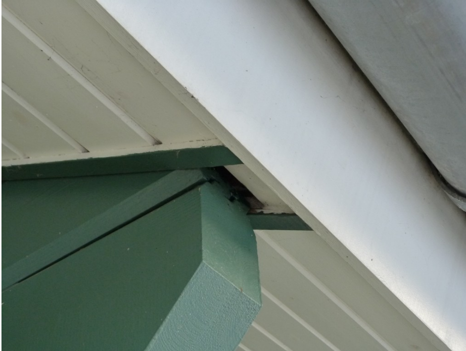
Figuur 4. Voor vleermuizen toegankelijke opening.
