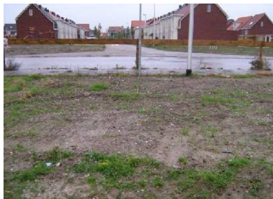
Foto 4: locatie-inspectie dd. 21-11-2012 Noordzijde locatie / Repaclaag
