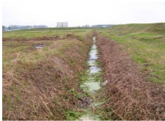
Foto 2: locatie-inspectie dd. 21-11-2012 Bestaande watergang / sloot
