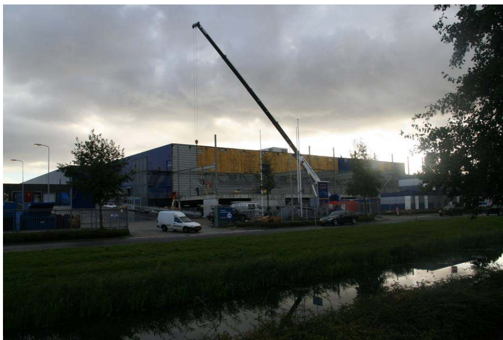
Figuur 7. Bouwwerkzaamheden IKEA.
