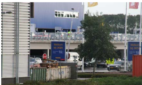
Figuur 28. Parkeergarage en -dek IKEA.
