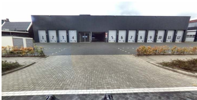
Figuur 30. Onderdoorgang aan de Arnhemseweg. Bron: Cyclomedia.
