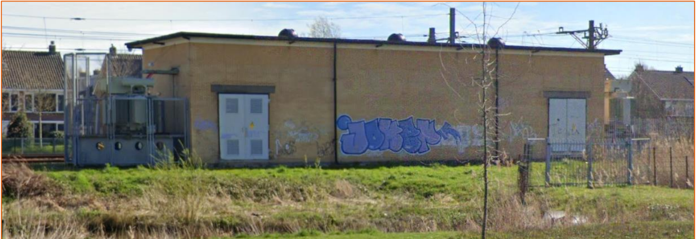
Figuur 1-4: Foto van huidige onderstation vanaf de westkant van de spoorbaan.
