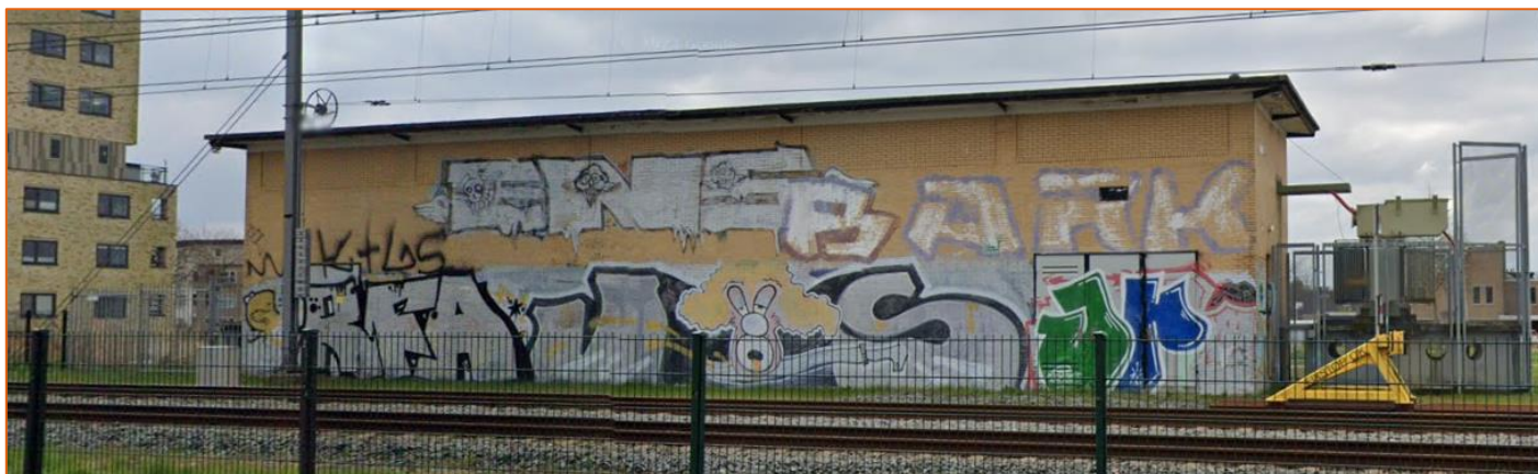
Figuur 1-3: Foto van huidige onderstation vanaf de oostkant van de spoorbaan.
