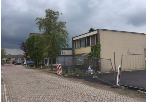
Figuur 3.3 Bestaande situatie plangebied
