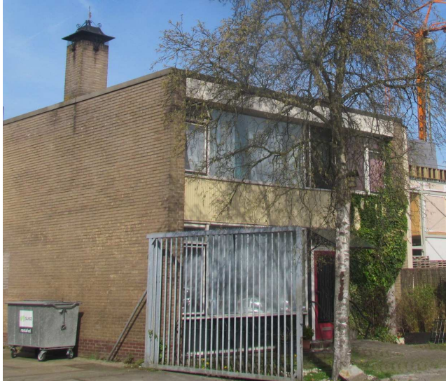
Spouwmuren linker- en rechterzijde W Kloosstr 64: mogelijk geschikt voor dwergvleermuizen
