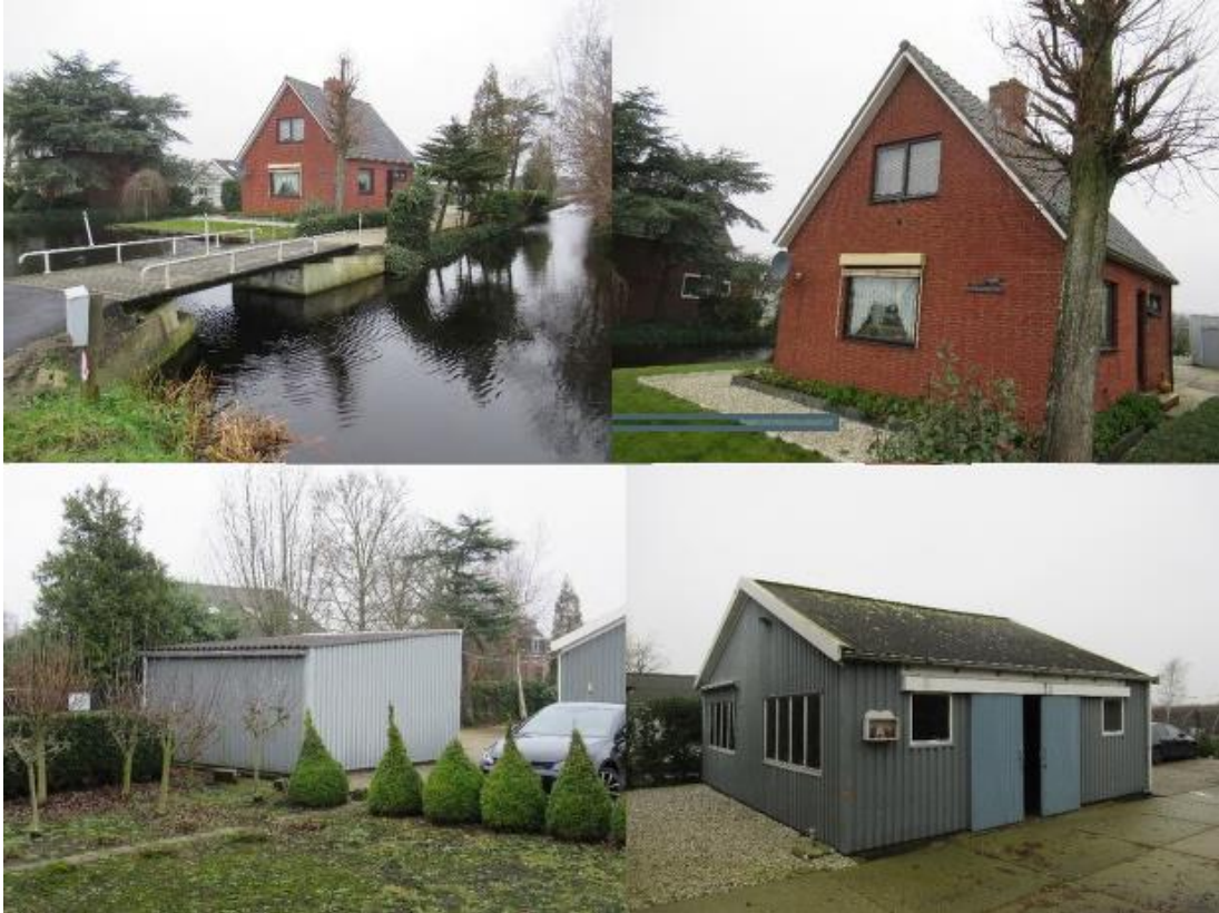
Afbeelding 4 foto's bestaande woning, garage en schuur
