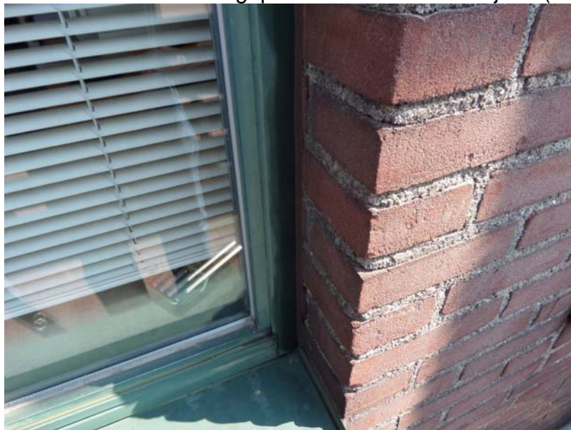
Foto 8: siliconen kit toegepast naast de raamkozijnen (tussen steen en kozijn)
