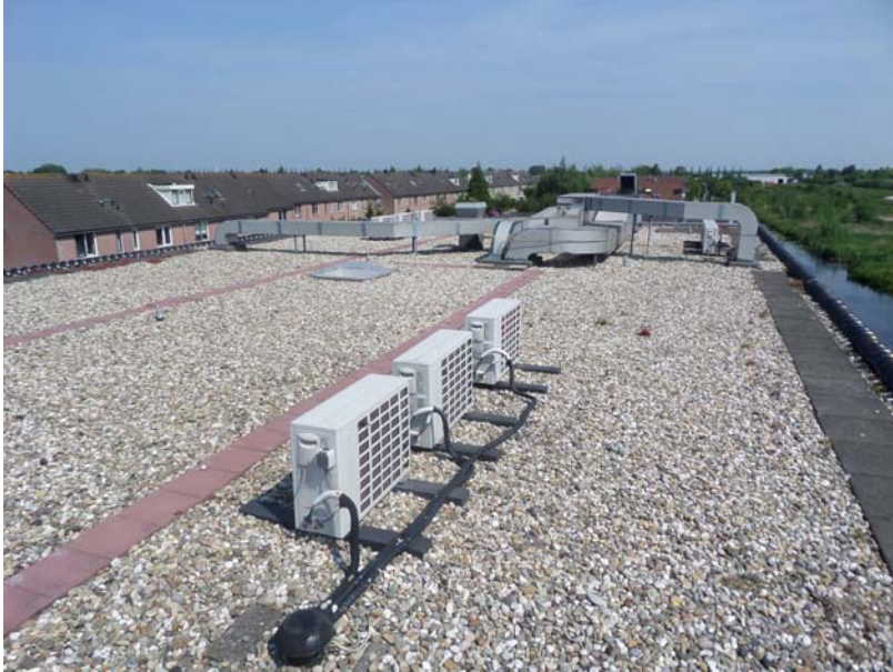
Foto 9: overzichtsfoto van het dak
