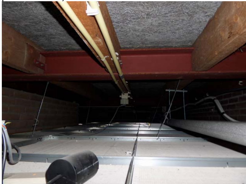
Foto 1: plafond 1 e verdieping (zachtboard beplating, stalen en houten binten en hwc platen als dak)
