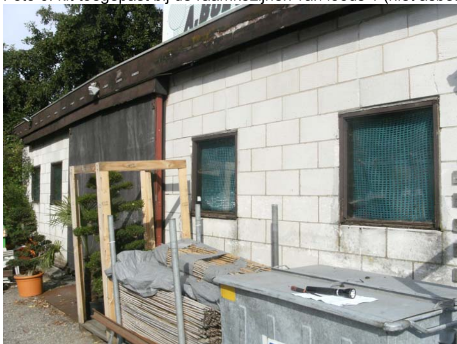
Foto 6: kit toegepast bij de raamkozijnen van loods 1 (niet asbesthoudend)
