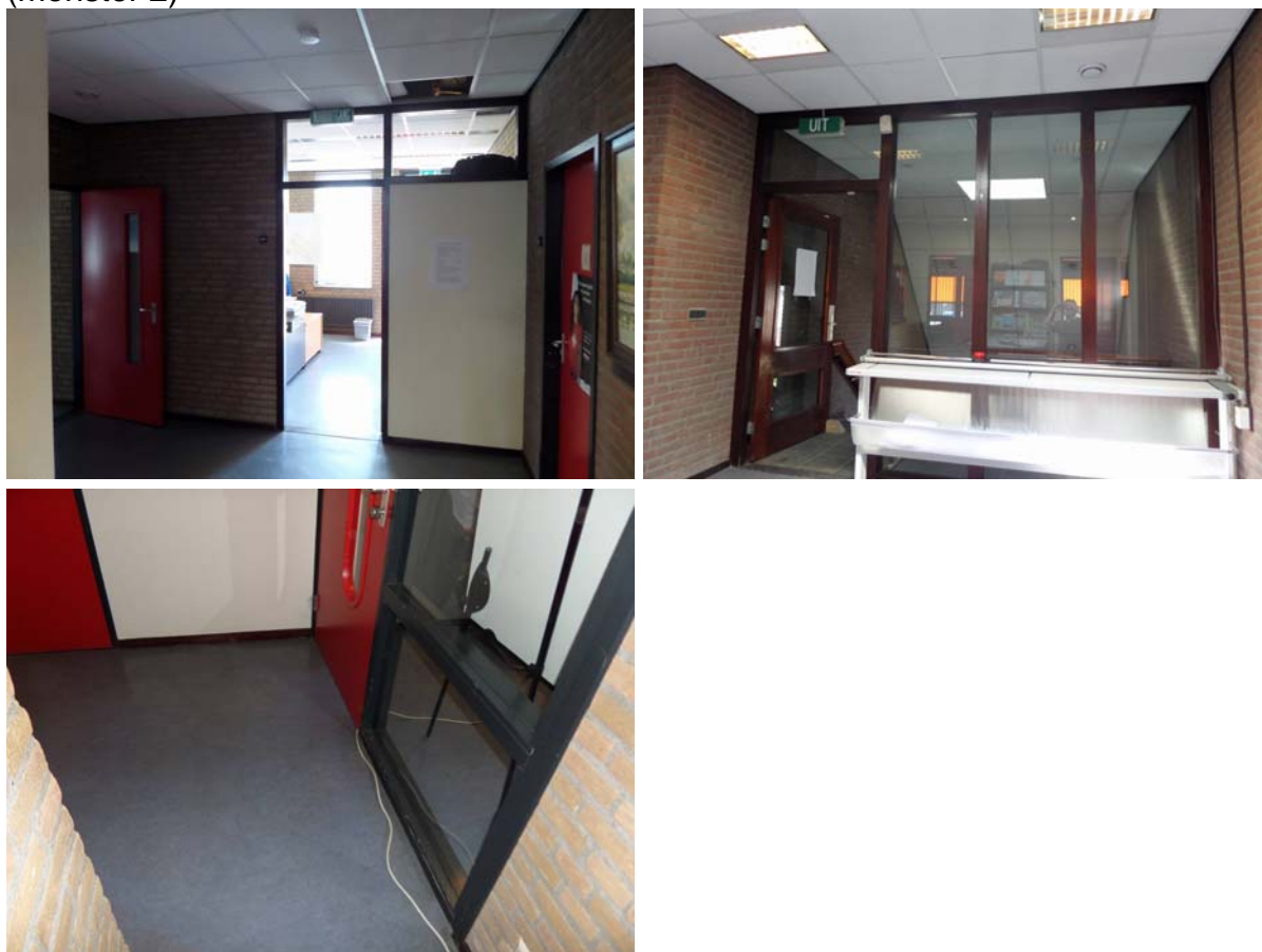
Foto 16: kit (rood) toegepast bij de binnen kozijnen is niet asbesthoudend (monster 2)
