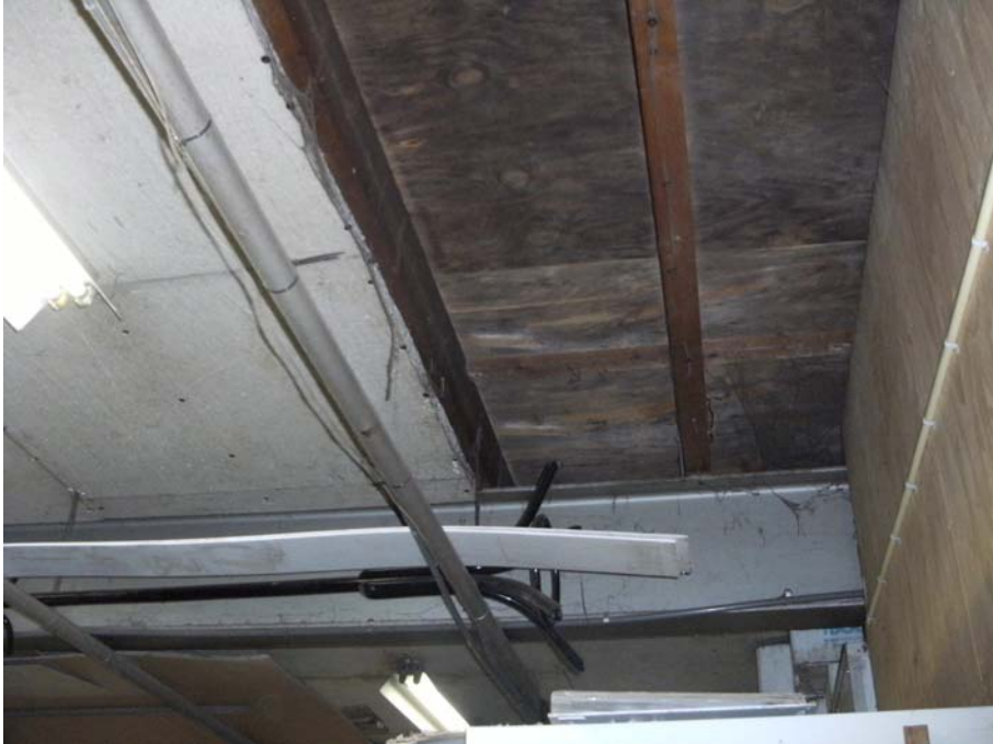
Foto 7: plafond van de loods is vervaardigd van staal en hout
