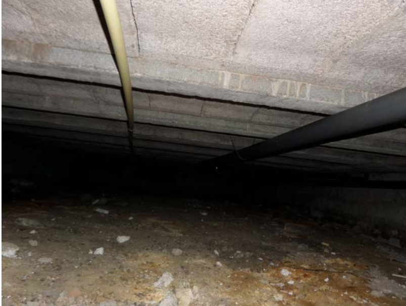
Foto 13: PVC riolering toegepast in de kruipruimte
