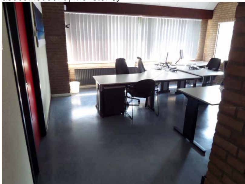
Foto 7: linoleum + lijmlaag op de betonnen vloeren door het gehele pand (niet asbesthoudend, monster 3)
