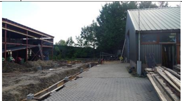
Rechts werkplaats 1, links werkplaats 2 wordt nu opnieuw gebouwd
